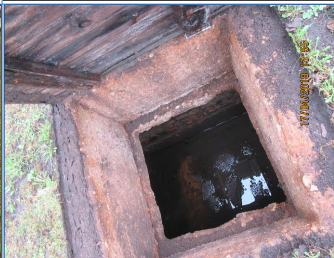
16. att. Satrupējušie fekālās kanalizācijas nosēdbedru koka vāks.
