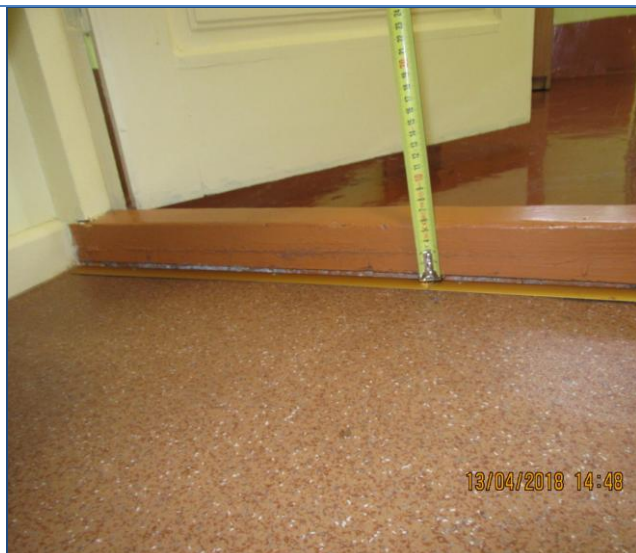
77. att. Neatbilstoši sliekšņi starp telpu grīdas līmeņiem, 6cm.
