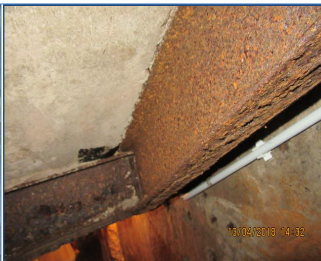
60. att. Korodējušas galveno kāpņu pirmā laiduma nesošās sijas un pasijas.
