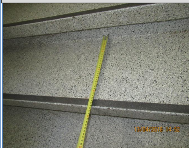
67. att. Pakāpiena platuma uzmērījums 35cm.
