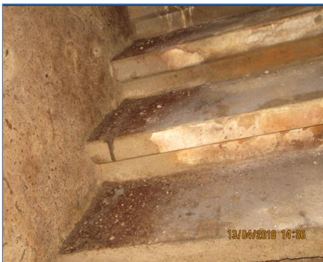
59. att. Mitruma bojātie pagraba pakāpieni.
