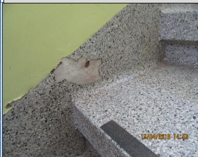
68. att. Mitruma bojātās pakāpienu sānu malas.
