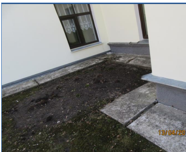
29. att. Ēkas virspamats bez būtiskiem bojājumiem.
