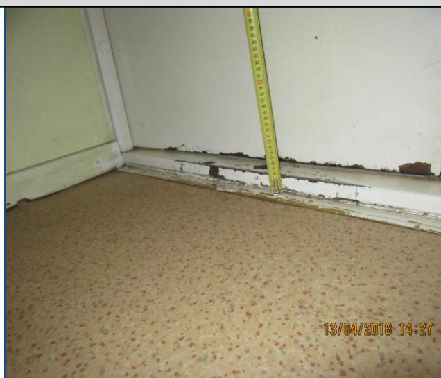
79. att. Neatbilstoši sliekšņi starp telpu grīdas līmeņiem.
