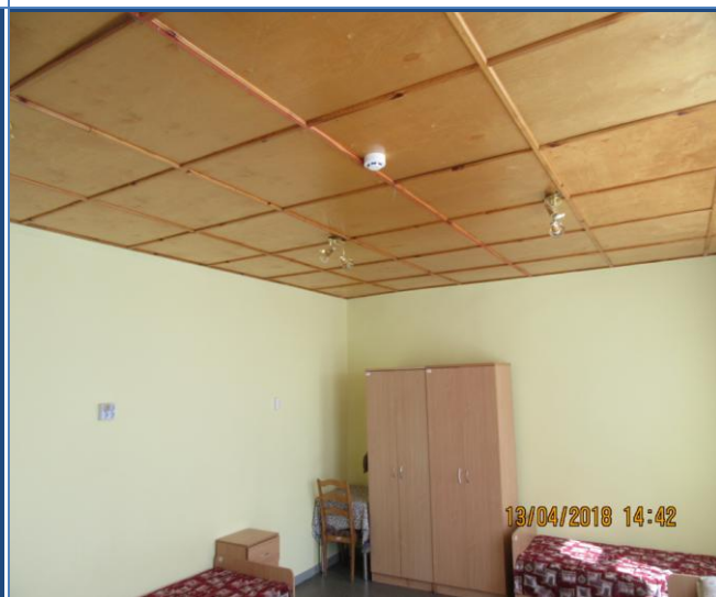
52. att. 2.stāva koka pārsegums ar griestu finierējumu.
