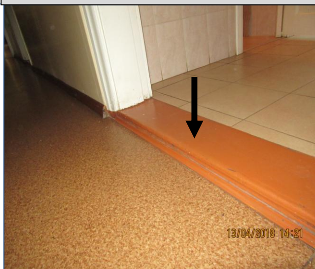
80. att. Neatbilstoši sliekšņi starp telpu grīdas līmeņiem.
