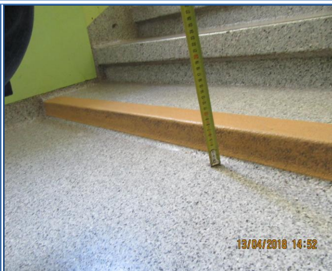
70. att. Neatbilstoša augstuma galveno kāpņu pirmā pakāpiena uzmērījums 7cm.
