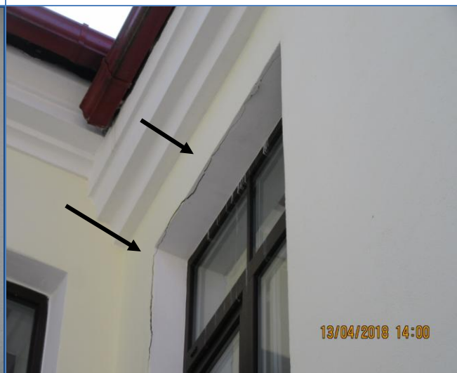
44. att. 2.stāva kāpņu telpas logu ailes plaisājums.
