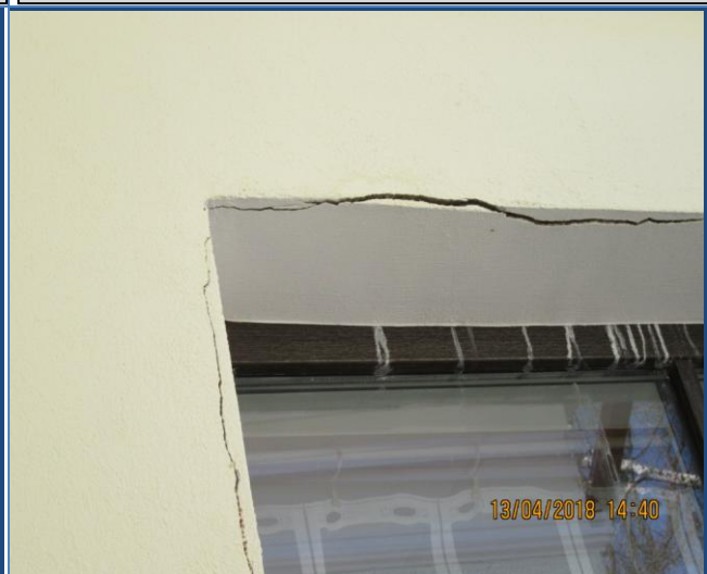
46. att. 2.stāva kāpņu telpas logu ailes plaisājums.
