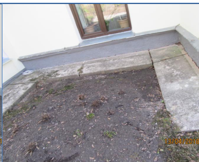
30. att. Ēkas apmale ar lokāliem iesēdumiem.
