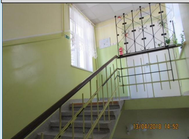
71. att. Kāpņu augšējā kāpņu laukuma drošības restojums.
