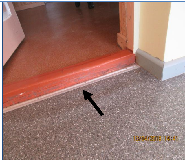
78. att. Neatbilstoši sliekšņi starp telpu grīdas līmeņiem.
