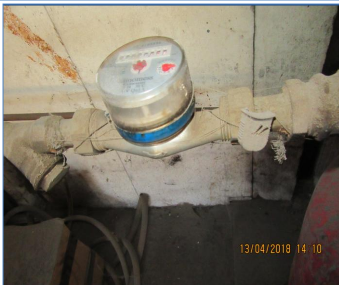
95. att. Ūdensvada ievads ar uzskaiti katlu telpā.
