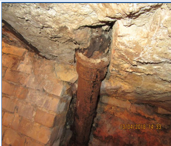
101. att. Ķeta kanalizācijas caurules savienojums pagrabā.
