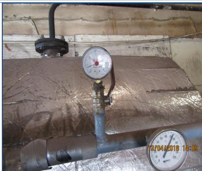
123. att. Esošā apkures granulu katla apsaite.
