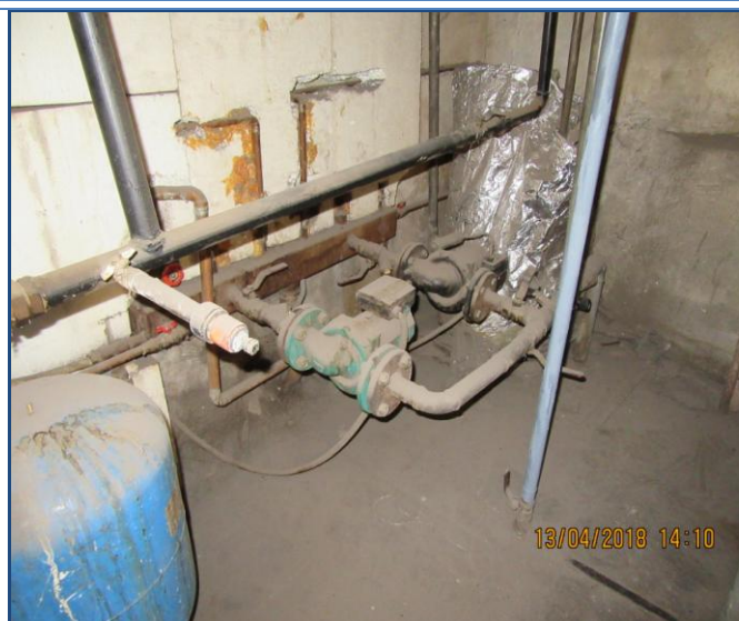
124. att. Esošā apkures granulu katla apsaite.
