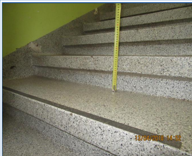
69.att. Pārējo pakāpiena augstuma uzmērījums 17cm.
