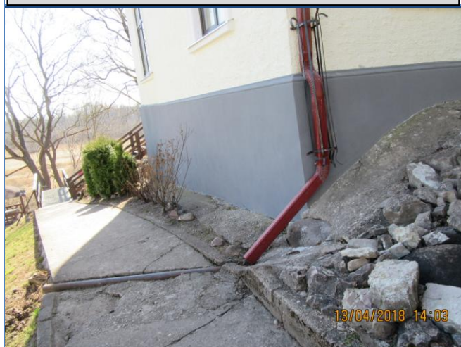
13. att. Bojātais iekšpagalma betona ietves segums. Ietve gar nogāzi bez drošības malas vai margas.
