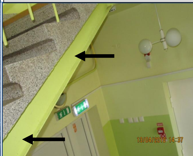
62. att. Uguns neaizsargātas galvenās kāpņu telpas nesošās tērauda sijas.
