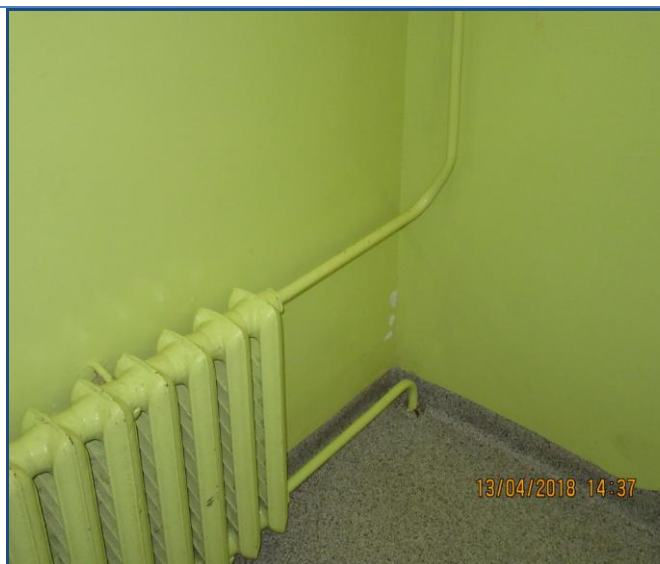
115. att. Čuguna apkures radiatora pieslēgums.
