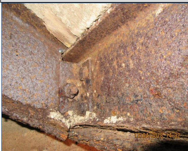
61. att. Korodējusi galveno kāpņu pirmā laiduma nesošā sija.
