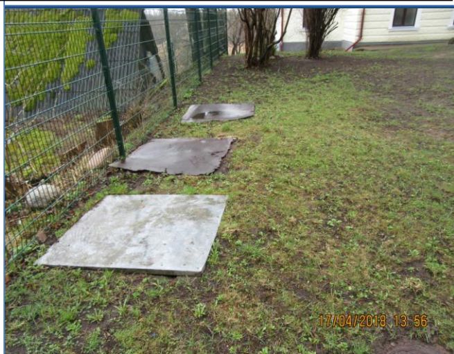
15. att. Satrupējušie fekālās kanalizācijas nosēdbedru koka vāki.
