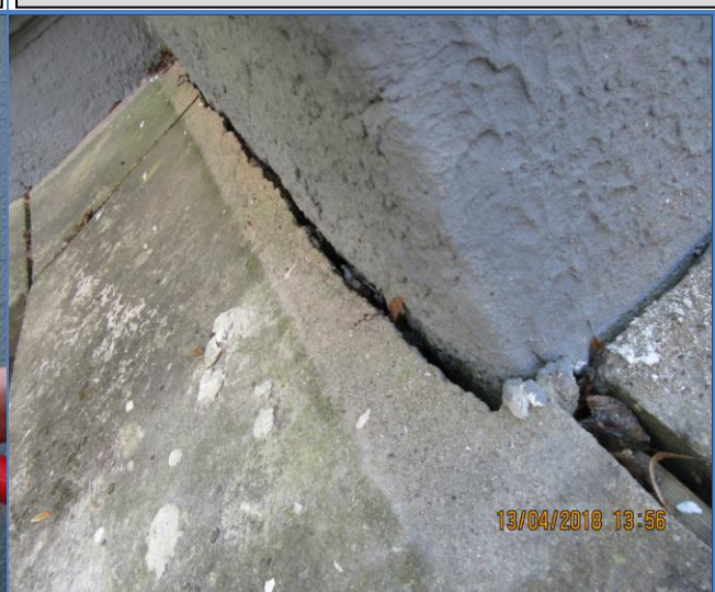
32. att. Ēkas apmale ar lokāliem iesēdumiem.
