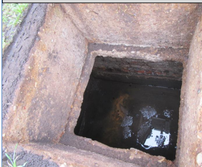
105. att. Priekšpagalma fekālās kanalizācijas nosēdbedre.
