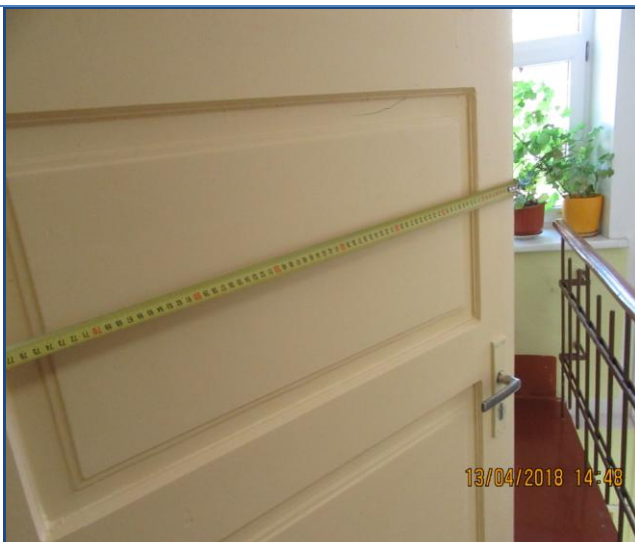
83. att. Neatbilstošas koka durvis uz kāpņu telpu.
